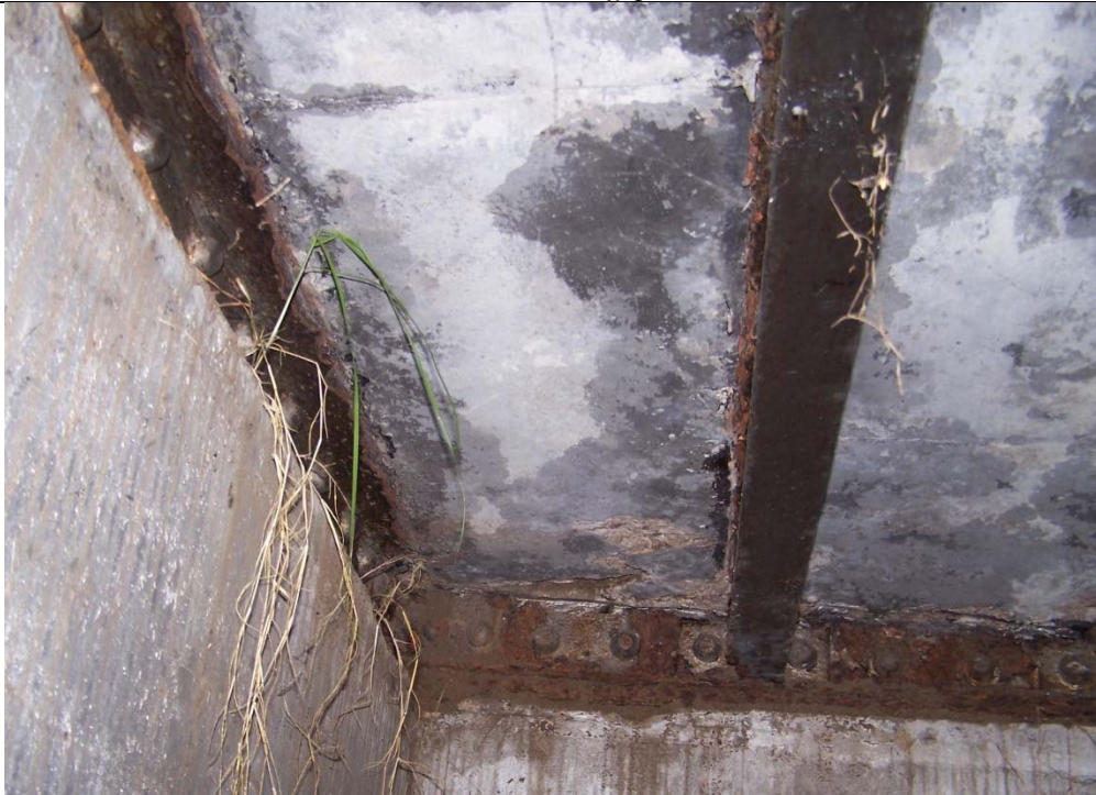
IHNC Lock Photo 04-23-2014No Materials070.jpg
